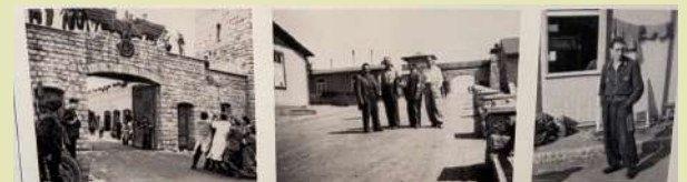
1. Vue du haut au-dessus du portail de la cage des églises de Mauthausen et arrosée par des détonas, le 5 mai 1945. Original : Corcu, V&HH 2. Ecole 1940, Pierre Hugué, Pierre Serge Choussat et Sida Haco sur le mode rampant au portail central du camp de Mauthausen. 1940. Photographie de K2. Collection 2010. H&HH 3. Marcel Desbrière, déporté républicain espagnol, membre du Front National, condamné sur la base de fausses lettres de Mauthausen, le 25 mai 1940. Document de Mauthausen/CAJAN
